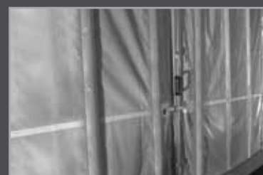
SISTEMA DI CHIUSURA E ANCORAGGIO CON CINGHIE INSIDE CLOSING SYSTEMS AND ANCHORING WITH CAM BUCKLE STRAPS
