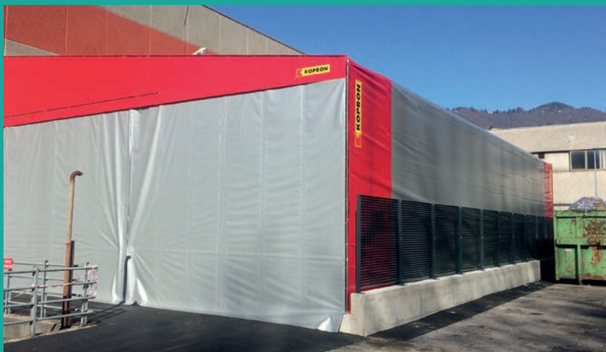
TENDOSTRUTTURA LATERALE MONOPENDENZA PER LA CROCE ROSSA - LIOMO (CO)
